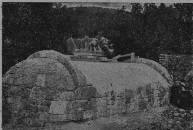
A Látogatás szentélye kívülről, építés közben.
